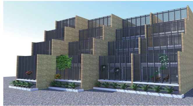
避難開始時：上層階に避難（通常階段利用） 浸水開始時：壁開放・水害救出装置展開開始 水位上昇時：バルコニー側は連続した水害救出装置を形成
